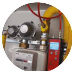
Logger pro časový záznam vývoje tlaku na síti
